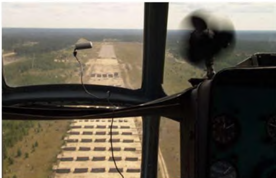
Остатки взлетно-посадочной полосы. Снято более 70% аэродромных плит
